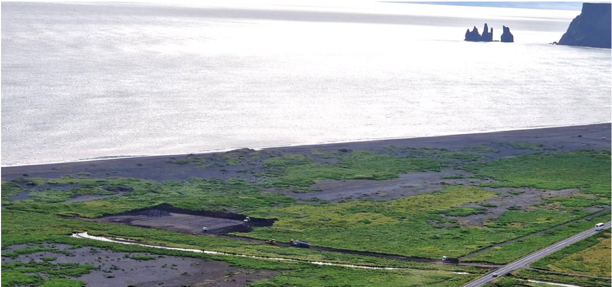
MYND 2.1 Horft yfir vinnslusvæði Lavaconcept ofan af Fagradalshamri. Myndin er tekin á framkvæmdatíma þegar unnið var að jarðvinnu. Svæðið er rétt við Þjóðveg 1 í lúpinubreiðu austan við Vík, Reynisdrangar sjást í fjarska.
